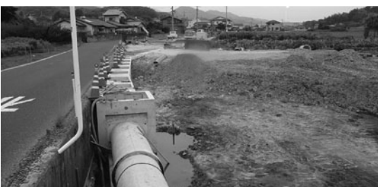
工事が進む 674号線(岩村)
