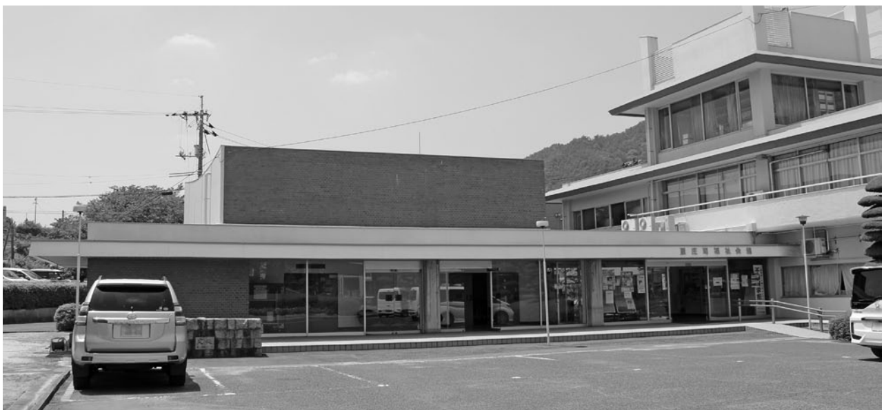
耐震工事を待つ福祉会館
