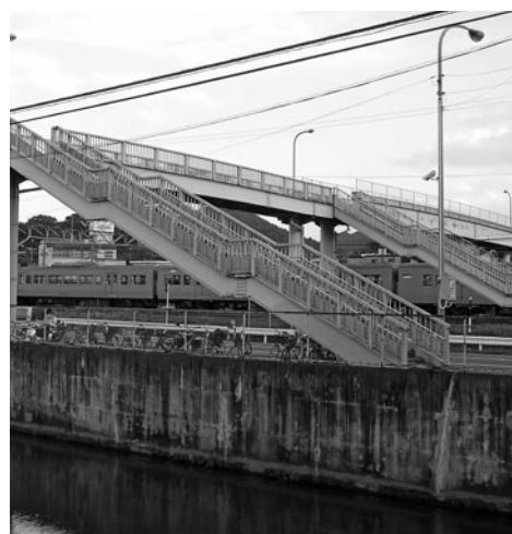
リニューアルを待つ歩道橋
