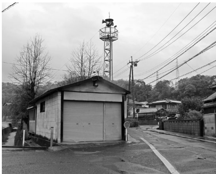
新設予定の11部消防機庫
