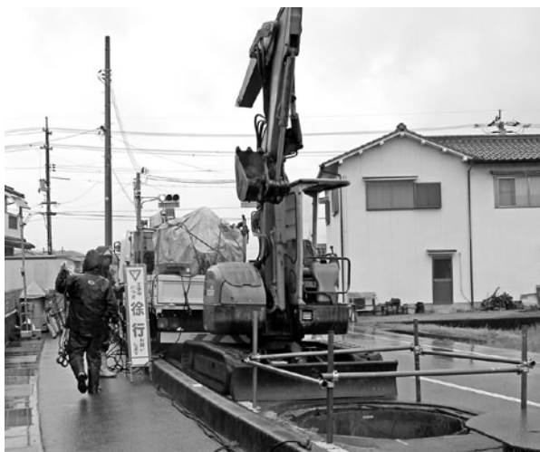
下水道工事(殿迫地区)
