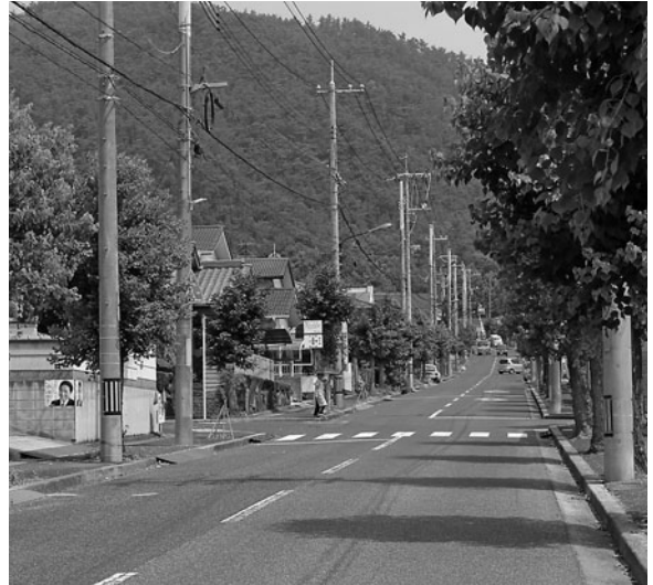
町道に建つ電柱(G・C)
