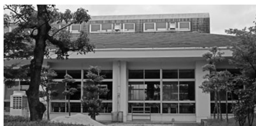
西小学校の給食棟
