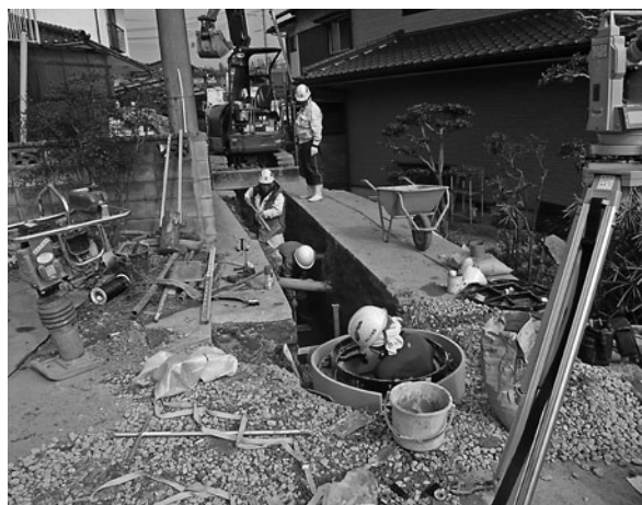
公共下水道工事(殿迫地区)
