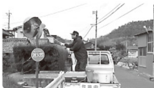
カーブミラーの点検清掃
