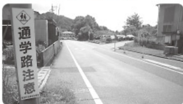
危険箇所への看板設置
