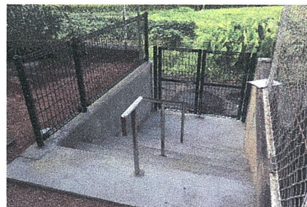
西幼：緊急避難経路整備
