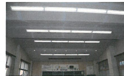
東小：音楽教室照明改修
