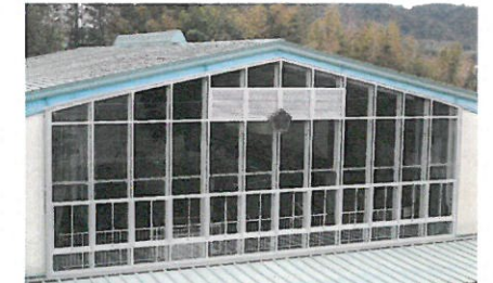
西小：体育館窓サッシ改修
