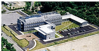
様々なベンチャー企業が入居する岡山県リサーチパークインキュベーションセンター(ORIC)
