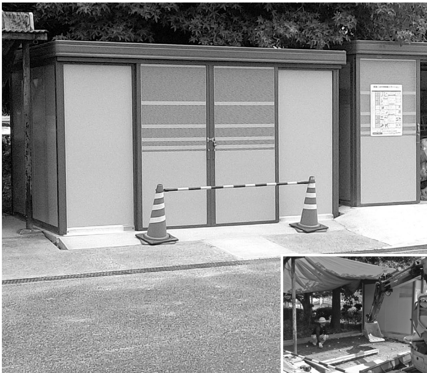
完成した役場前資源ゴミ収集庫
