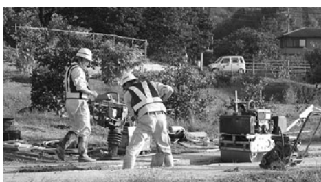
下水道工事(川南)
