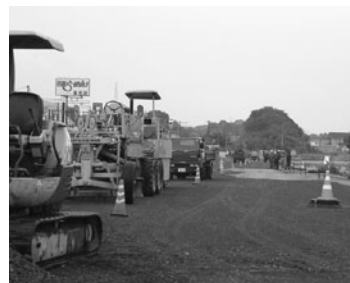
工事が進む 229号線
