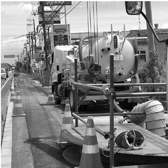
国道 2 号線沿いの下水道工事
