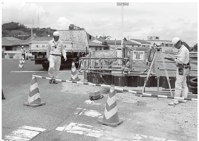
229号線の箱型函渠工事
