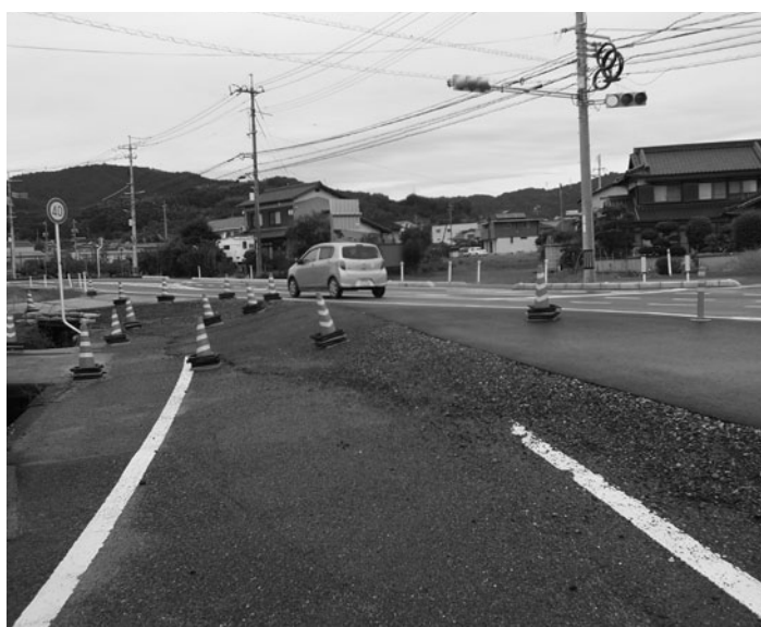
岩村交差点の残工事箇所
