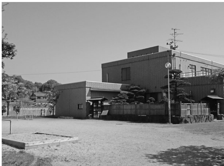
仮設トイレが設置される東公民館
