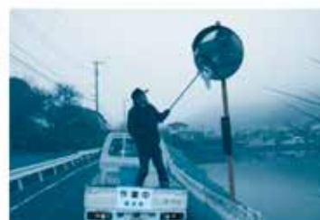
カーブミラーの点検・清掃
