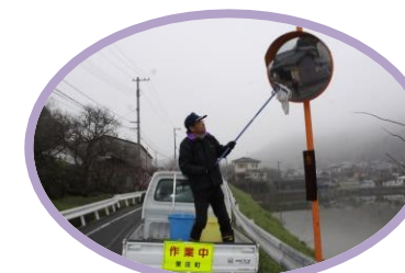
カーブミラーの点検・清掃
