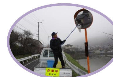
カーブミラーの点検・清掃
