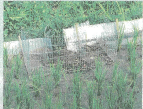
取水口に設置した金網
