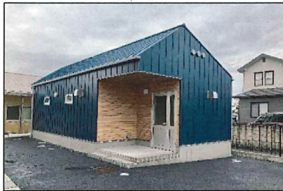
東小学校屋外トイレ棟（完了後）
