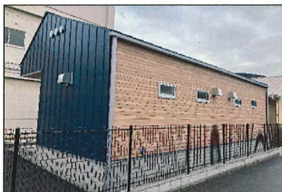
東小学校屋外トイレ棟（完了後）
