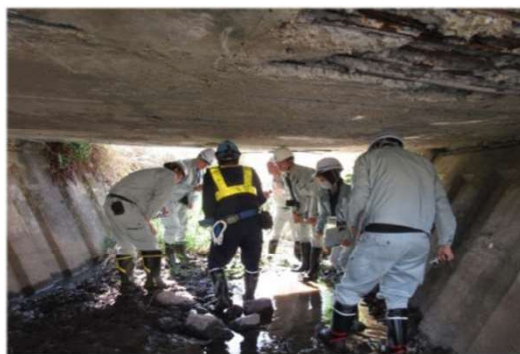
橋梁点検実習状況
