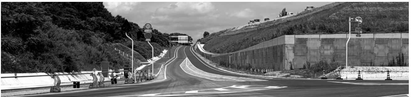
玉島笠岡道路建設中（金山地区）
