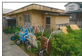
東小学校屋外トイレ棟（着手前）
