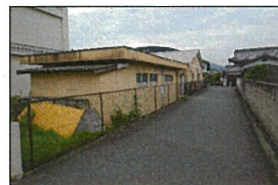
東小学校屋外トイレ棟（着手前）
