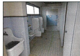
東小学校屋外トイレ内部（着手前）
