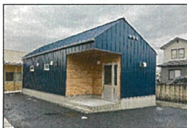
東小学校屋外トイレ棟（完了後）
