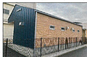
東小学校屋外トイレ棟（完了後）
