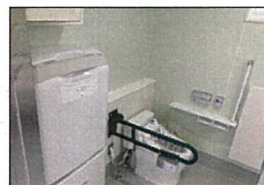
東小学校屋外トイレ内部（完了後）
