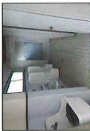
東小学校屋外トイレ内部（着手前）
