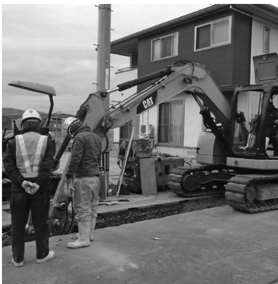
進めている下水道工事(屋中)
