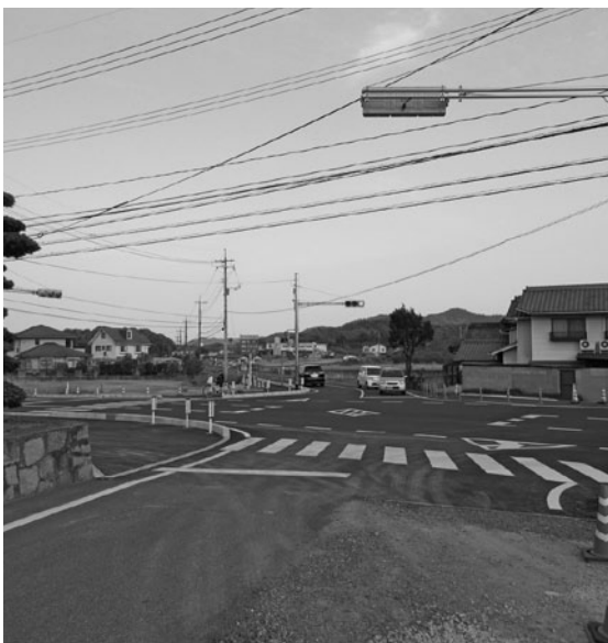
灯入れした岩村交差点信号機
