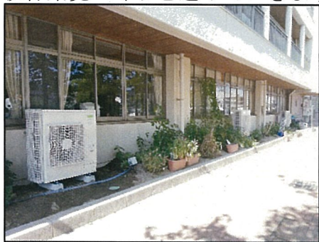
里庄東小学校空調整備
