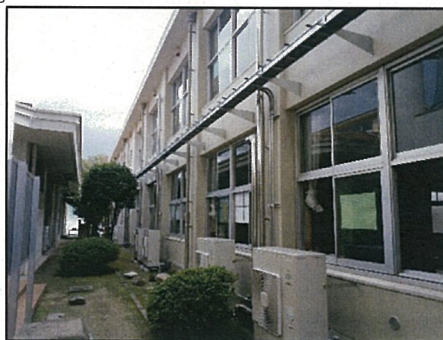
里庄西小学校空調整備
