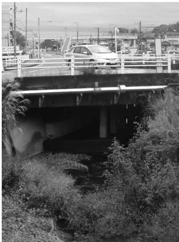
改修される石橋(駅西踏切付近)
