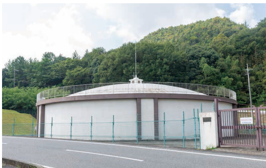
里庄北配水池
