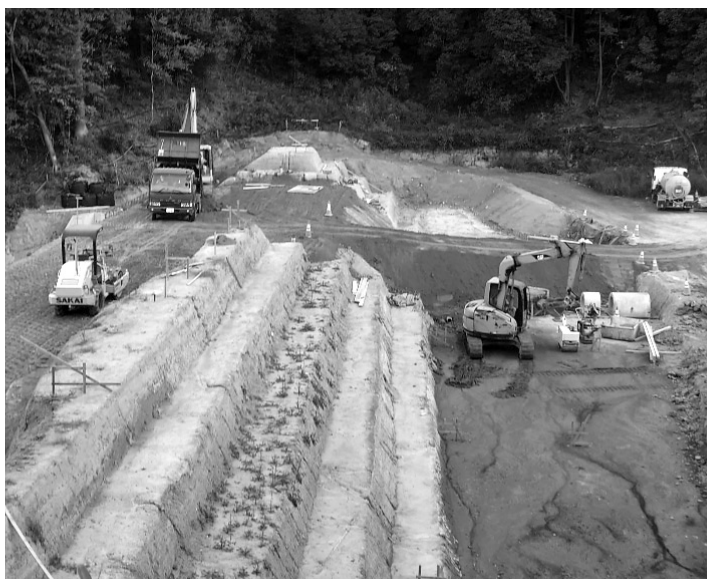
工事が進む奥迫池
