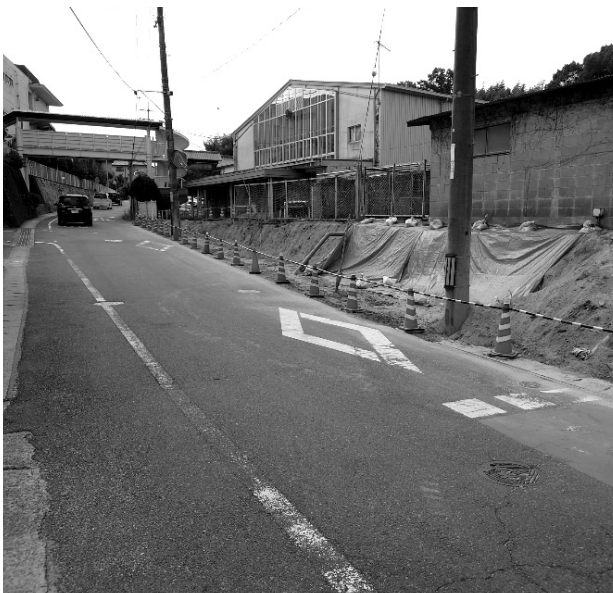
西小学校西側道路拡幅工事
