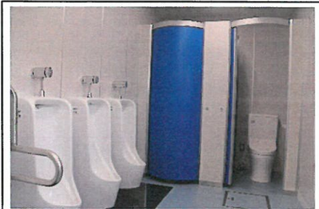
西小学校児童専用トイレ改修
