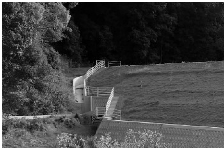
工事完了した奥迫池
