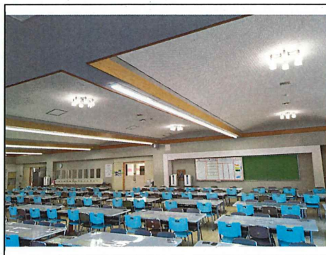
東小学校ランチルーム LED 化改修
