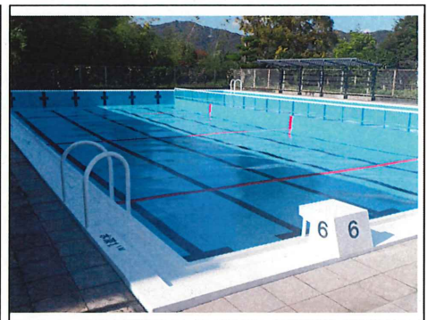
西小学校体育プール塗装改修
