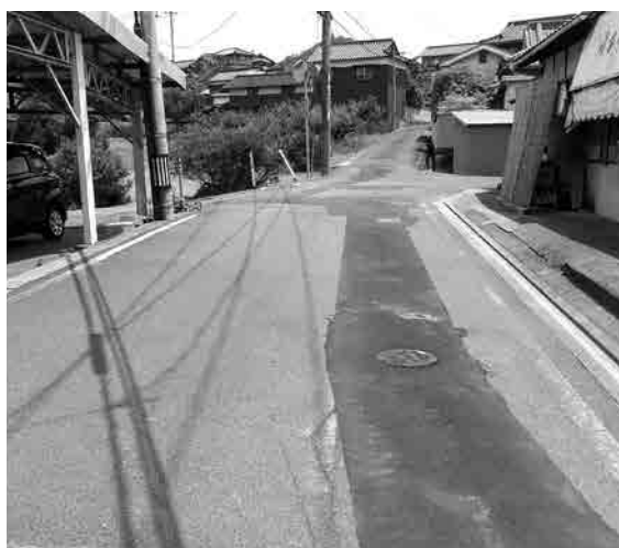
舗装を残し工事が完了した下水道工事(狭田地区)
