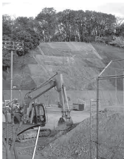
改修工事中のつばきの丘運動公園
