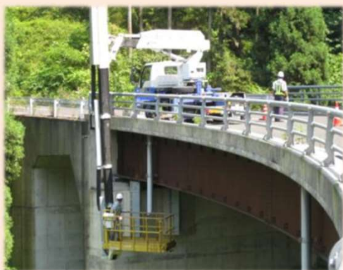
橋梁点検車による点検
