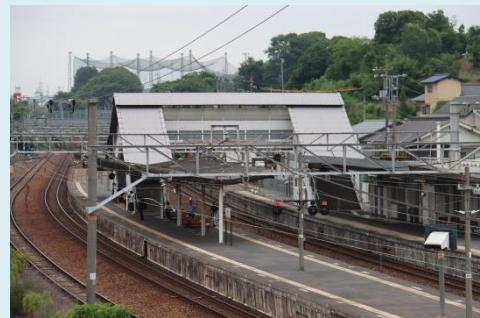
里庄駅の跨線橋
