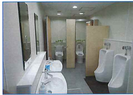
②中学校校舎内トイレ（完了後）
