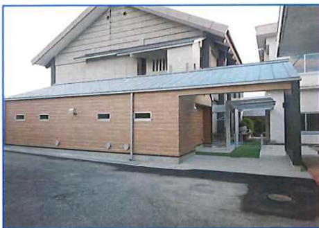
①中学校屋外トイレ棟（完了後）
