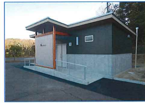
③野球場屋外トイレ棟（完了後）
