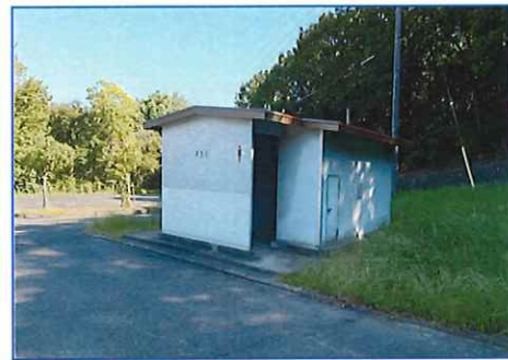
③野球場屋外トイレ棟（着手前）
