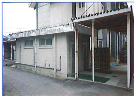
①中学校屋外トイレ棟（着手前）
