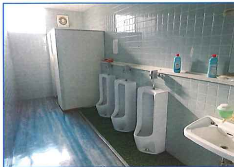
②中学校校舎内トイレ（着手前）
